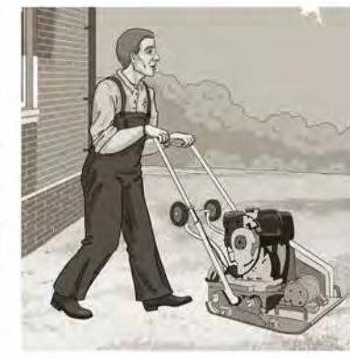
Основание обязательно утрамбовывается. Применять для уплотнения основания ручные трамбовки «бабы» не следует, поскольку с их помощью трудно обеспечить равномерность подготовки.
