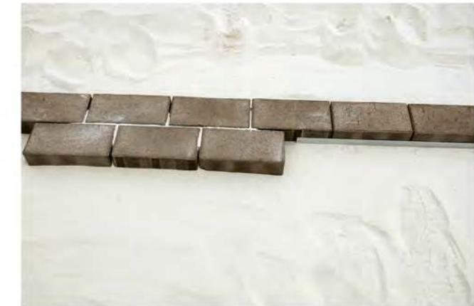
**6.** Обязательно качественное заполнение швов абсолютно сухим песком, либо послойное заполнение влажным песком с последующей проливкой за 2-3 раза. В процессе эксплуатации участка, в случае вымывания песка, производится просыпка швов.
