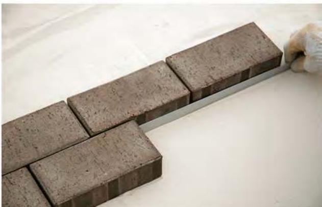
**3.** При несовпадении вертикальных и горизонтальных швов выполняется «разгонка» швов каждого ряда вручную.
