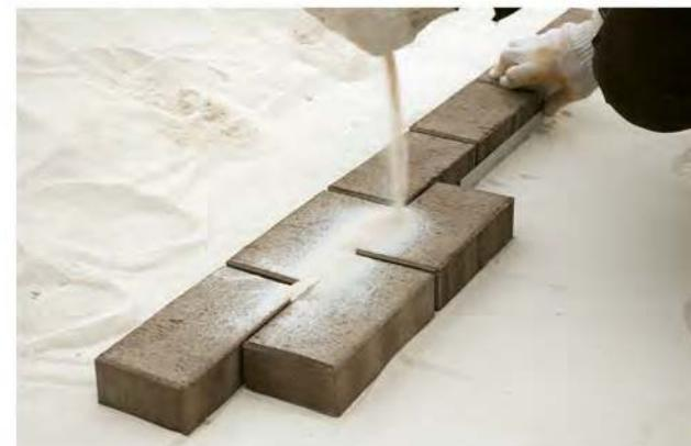
**5.** Швы заполняются сеянным песком, модуль крупности которого не должен превышать размеры шва.
