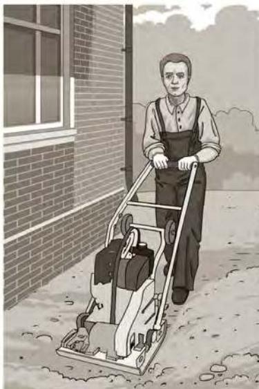
Качественное выполнение работ по подготовке основания на больших площадях может быть обеспечено при использовании автотракторной техники: бульдозер, грейдер, каток и пр.. Участки площадью до 100-150 кв.м, а также участки сложной формы, удобней подготавливать с помощью специального электро- и бензоинструмента (виброплита, виброрейка и пр.)
