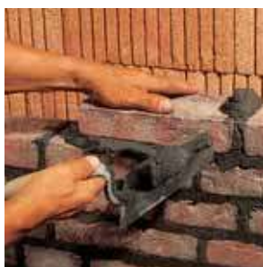
2. Выдавливаемый кладочный раствор не обламывается и после зачистки мастерком может использоваться повторно. Воздушная прослойка не закупоривается, потеря раствора почти нет.
