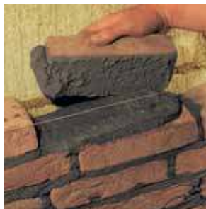
По основанию приподнятого кирпича видно, что достигается сплошное сцепление раствора с основанием камня и сплошное заполнение шва раствором по всей поверхности.
