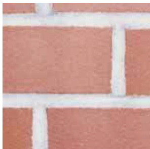
Разглаженный шлангом шов. Возможно также получение шероховатого шва с грубоватой обмазкой типа рустика, если его, например, обработать щеткой.
