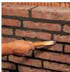
3. Кладка и расшивка швов производятся одновременно. Швы надавливая приглаживают. В зависимости от обработки получается гладкая или шероховатая поверхность швов.
