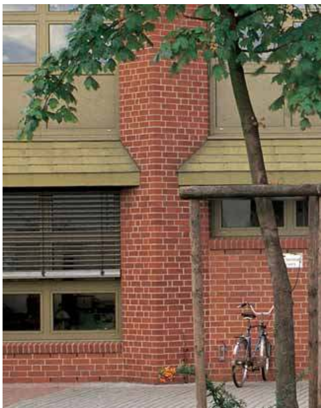
Перекрытие относительно высоты камня
