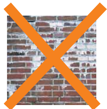
Полное прочное сцепление раствора марки V.O.R. фирмы "Квик-микс" предотвращает "блуждание" воды внутри каменной кладки, которое ведет к так называемым выщелачиваниям или к появлению налета извести
